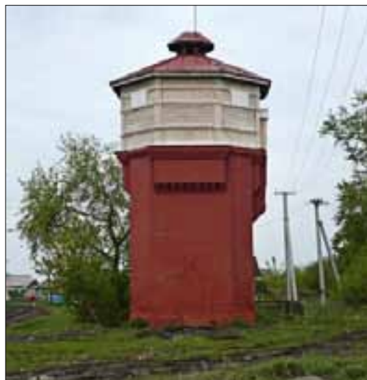
Отреставрированная водонапорная башня
