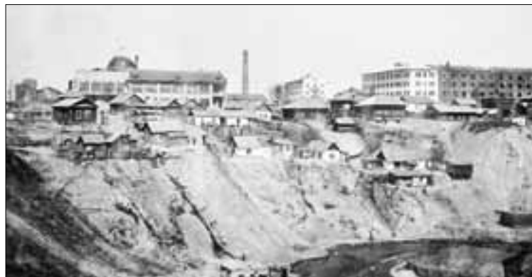
Ельцовка. Вид на фабрику-кухню и дома РЖСКТ «Красный Кожевник», 1934 г.
