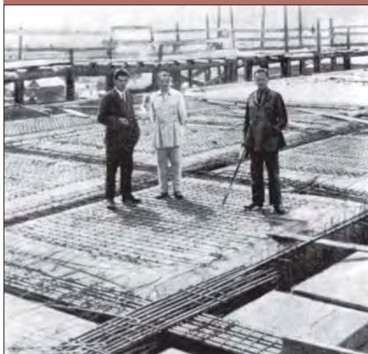
Железобетонное перекрытие здания Сибкрайсоюза. 1926 г. Крайний справа А.Д. Крячков
