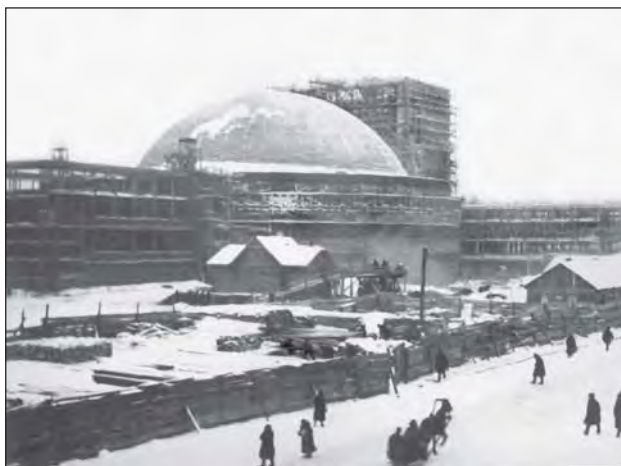
Строительство Дома науки и культуры в 1933 г.
