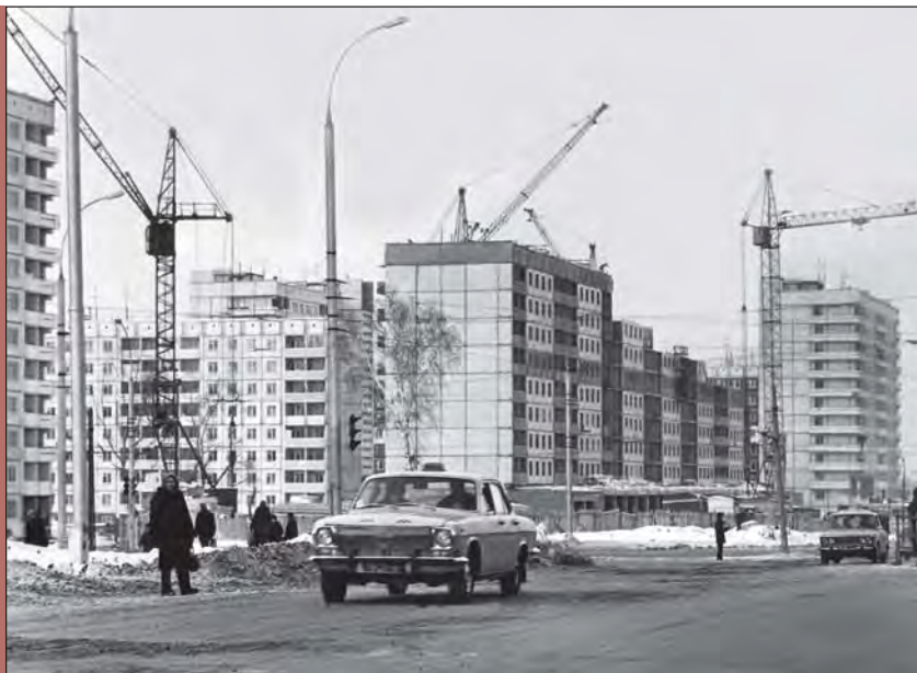
Строительство Челюскинского жилмассива. 70-е годы
