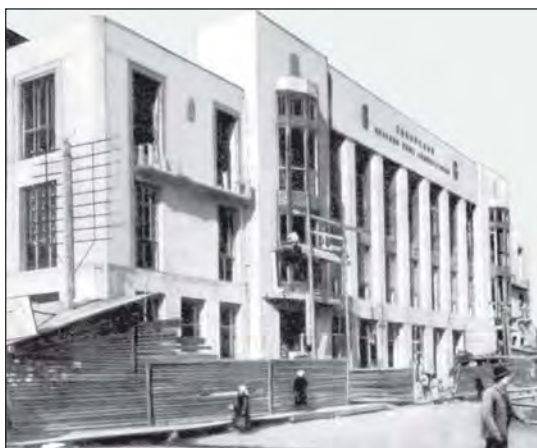
Строительство здания Сибкрайсоюза
