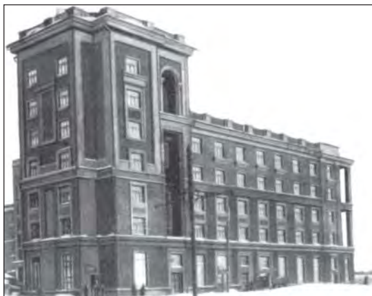
Жилой дом Соцгорода «Сибметаллстрой» по ул. Станиславского. Арх. В.М. Тейтель, Б.А. Биткин, Д.И. Кузьмин, Н.Г. Васильев и др.
