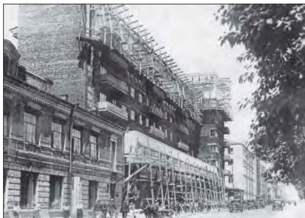
Строительство жилого дома Крайснаббыта. 1932 г.
