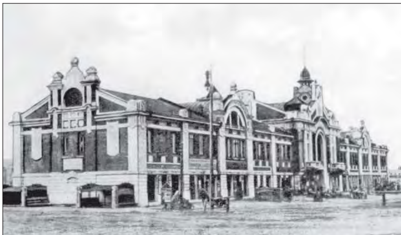
Городской торговый корпус в центре Ярмарочной площади. Архитектор А.Д. Крячков
