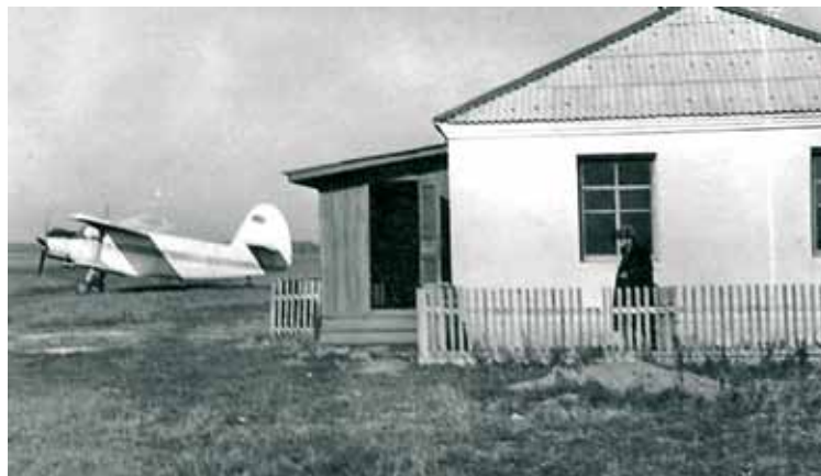
Здание аэровокзала в Усть-Тарке
