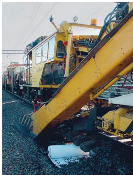
Вырезка земляного полотна машиной СЧ-601
