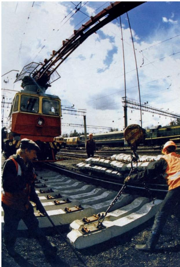
Укладка рельсов на бетонные шпалы
