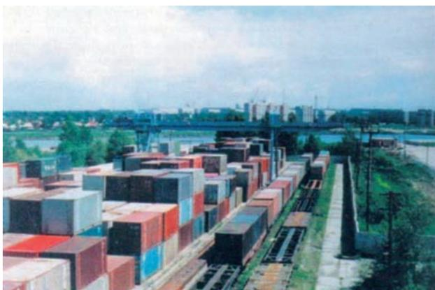
Станция Клещиха. Механизированная площадка для переработки грузов в 20-тонных контейнерах
