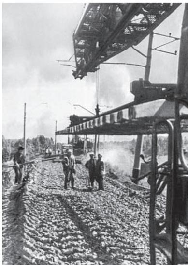
Укладка пути на железобетонных шпалах укладочным краном УК-25 при капитальном ремонте пути
