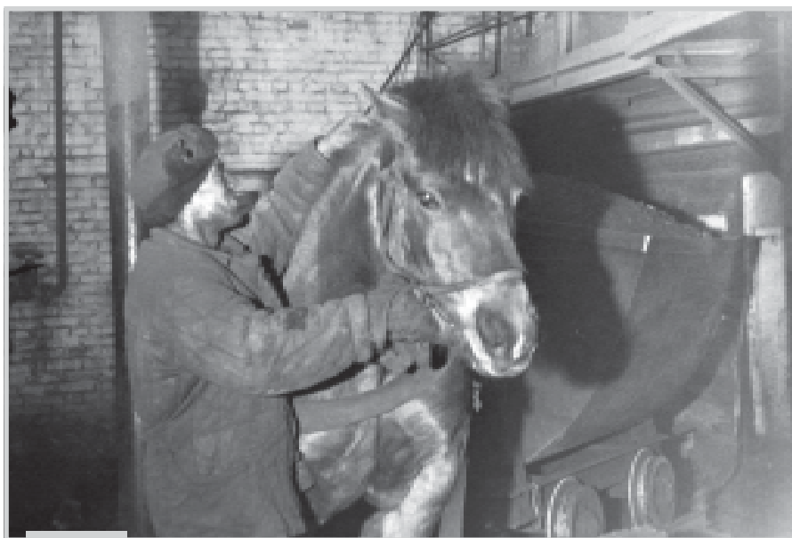
В котельной спиртзавода. 1960-е годы
