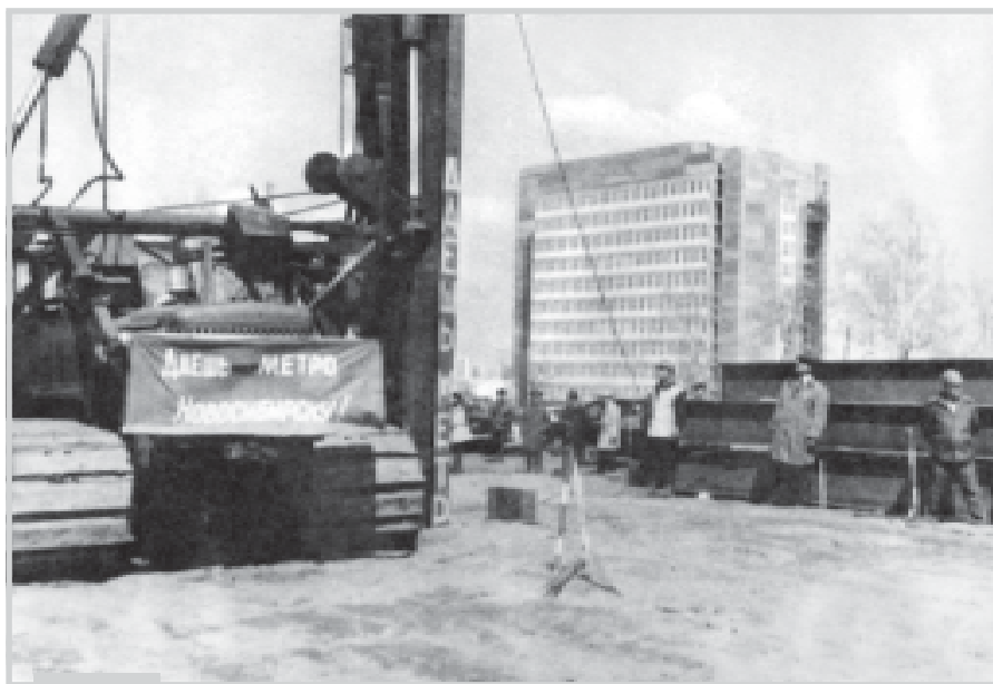
Забивка первой сваи крепления котлована станции «Октябрьская»
