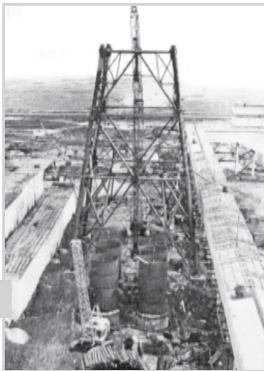
Монтаж первой трубы цеха обжига
