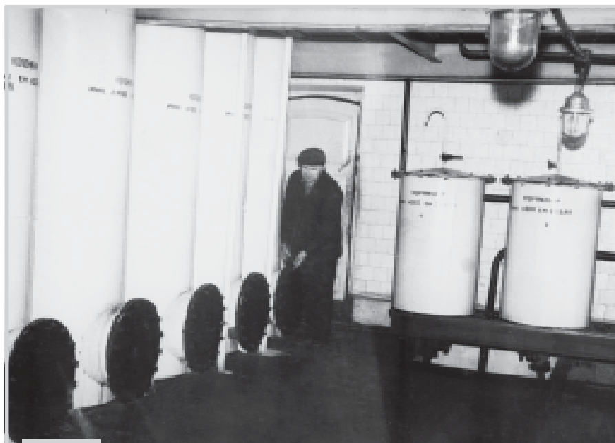
Очистное отделение водочного цеха
