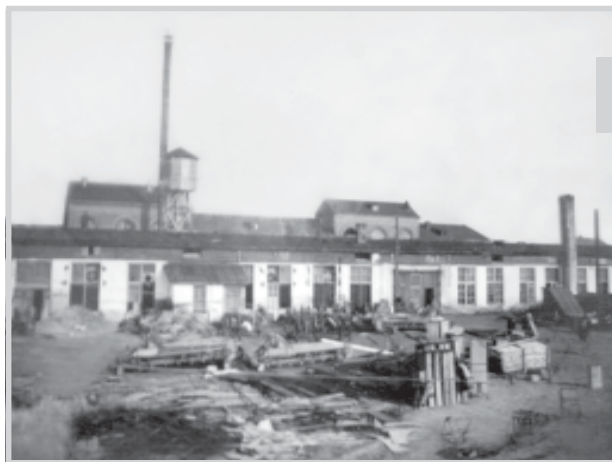
Общий вид механо- сборочного цеха, построенного в 1933 г.
