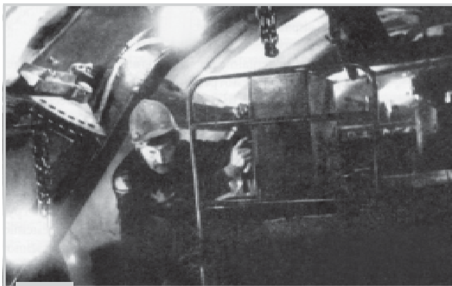
Машинист проходческого щита участка □ 3 ТО-29 В. Алтунин. 1983 г.
