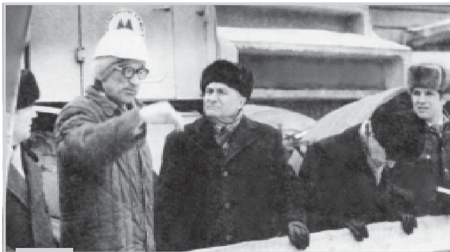
Начальник ТО-29 В.А. Колточихин докладывает первому секретарю ОК КПСС А.П. Филатову о ходе строительства
