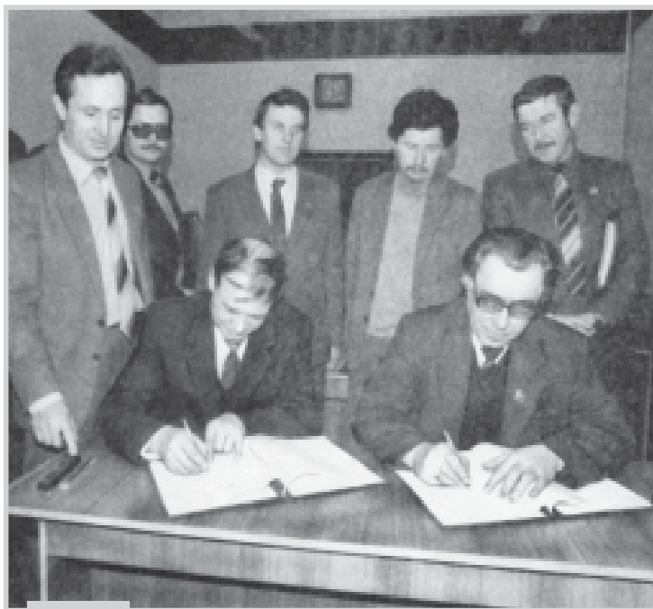
Подписание Акта рабочей комиссии по приемке 1-го пускового участка Ленинской линии метрополитена
