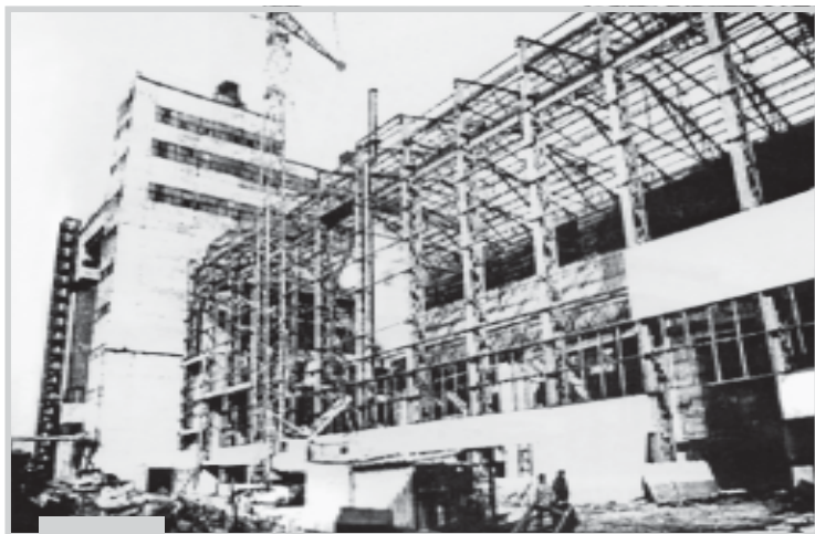
Строительство корпуса прокалочного цеха
