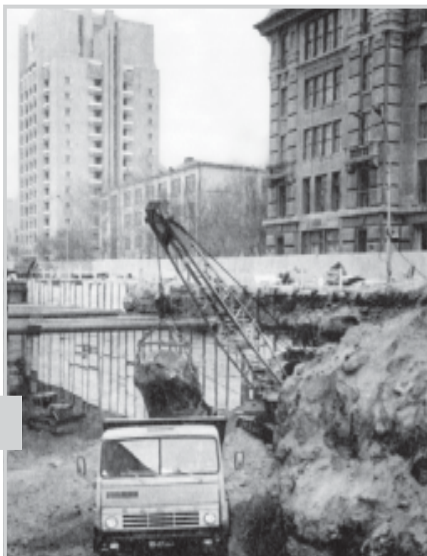
Разработка грунта в котловане ст. «Площадь Ленина»
